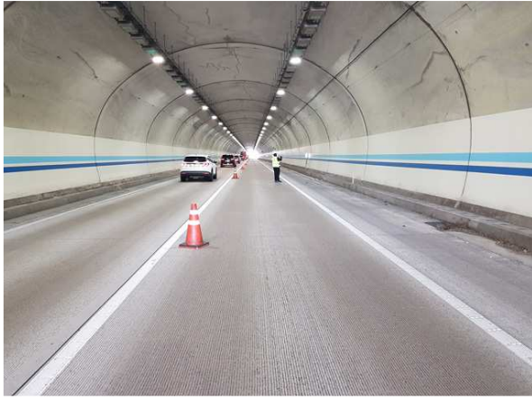
도보점검을 통한 근접조사
