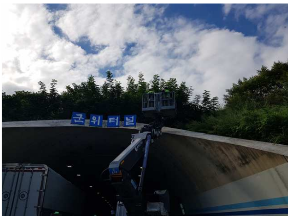
고소차를 이용한 근접조사
