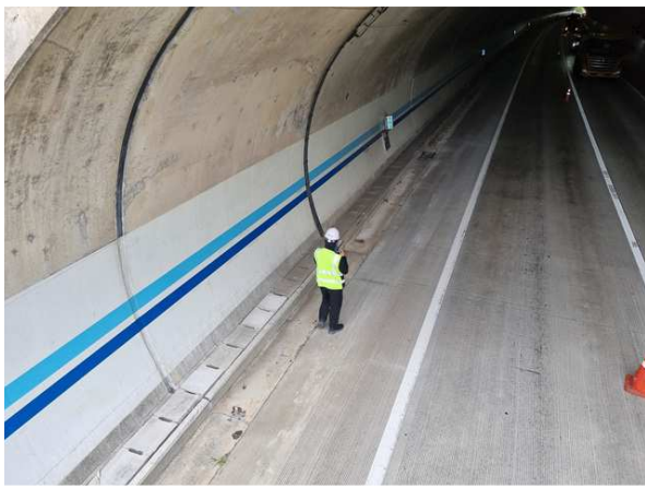
도보점검을 통한 근접조사
