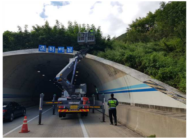
고소점검차를 이용한 근접조사
