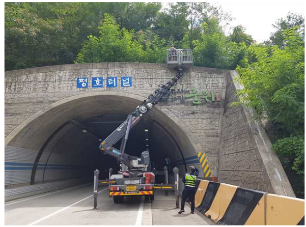
고소점검차를 이용한 근접조사
