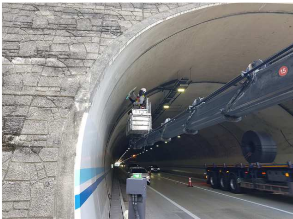
고소점검차를 이용한 근접조사
