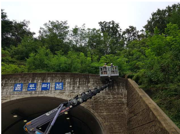
고소점검차를 이용한 근접조사
