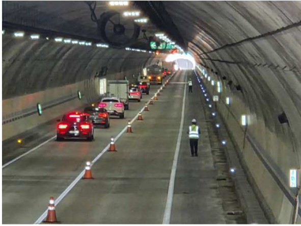
도보점검을 통한 근접조사
