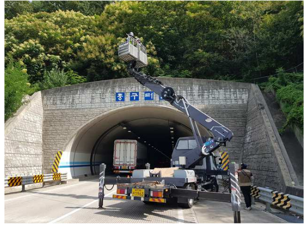
고소점검차를 이용한 근접조사
