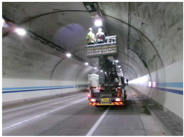
고소점검차를 이용한 근접조사
