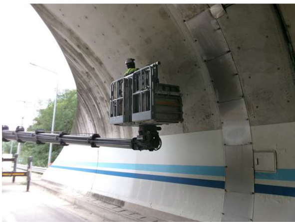
고소점검차를 이용한 근접조사
