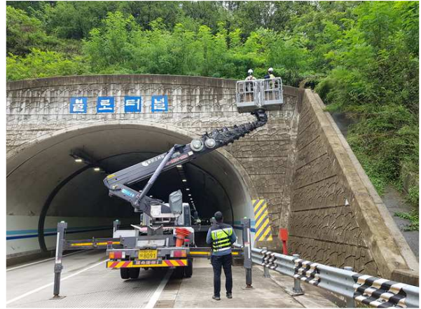
고소점검차를 이용한 근접조사
