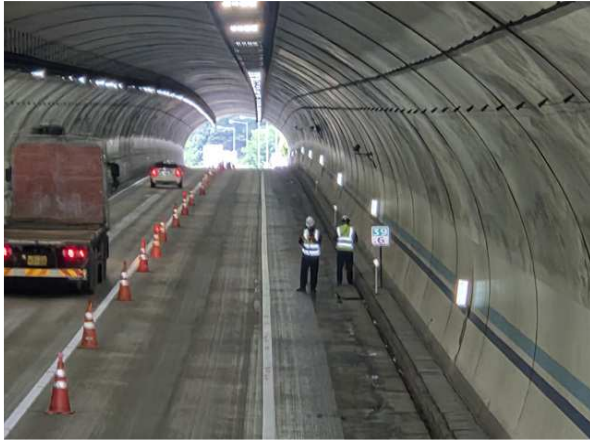
도보점검을 통한 근접조사
