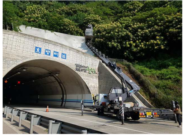
고소점검차를 이용한 근접조사
