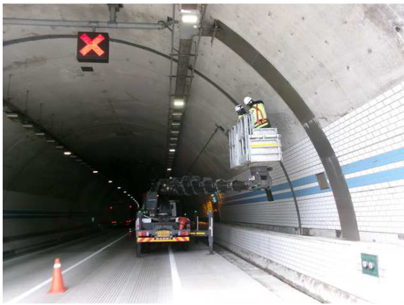
고소점검차를 이용한 근접조사
