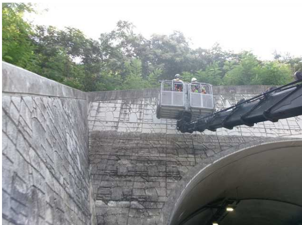
고소점검차를 이용한 근접조사
